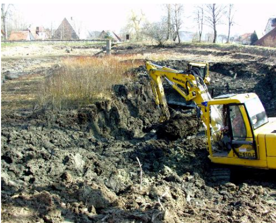
Bild 7: Entschlammung eines Weihers
